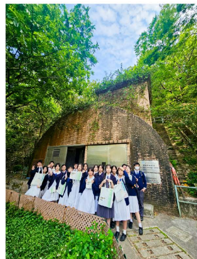
地理科參觀 寶珊排水隧道 山泥傾瀉科技展學館
